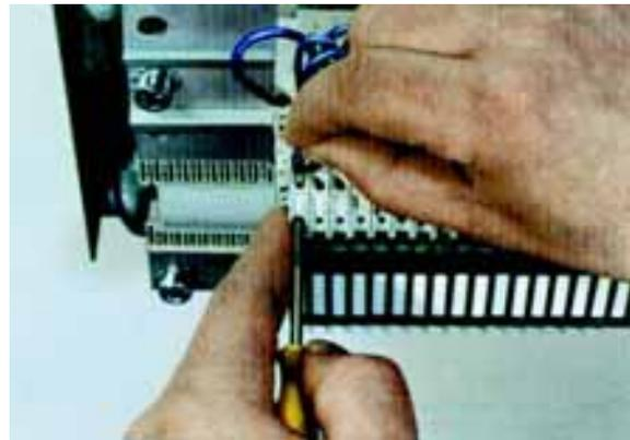
Подключение провода к пружинному контактному зажиму
