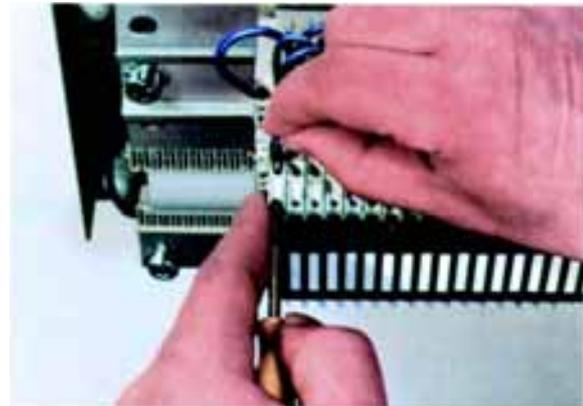
Подключение провода к пружинному контактному зажиму
